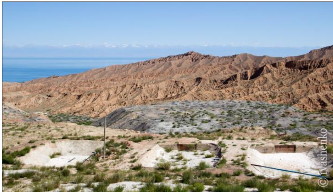
Рис. 5. Каджи-Сайское хвостохранилище урановых отходов [6].
