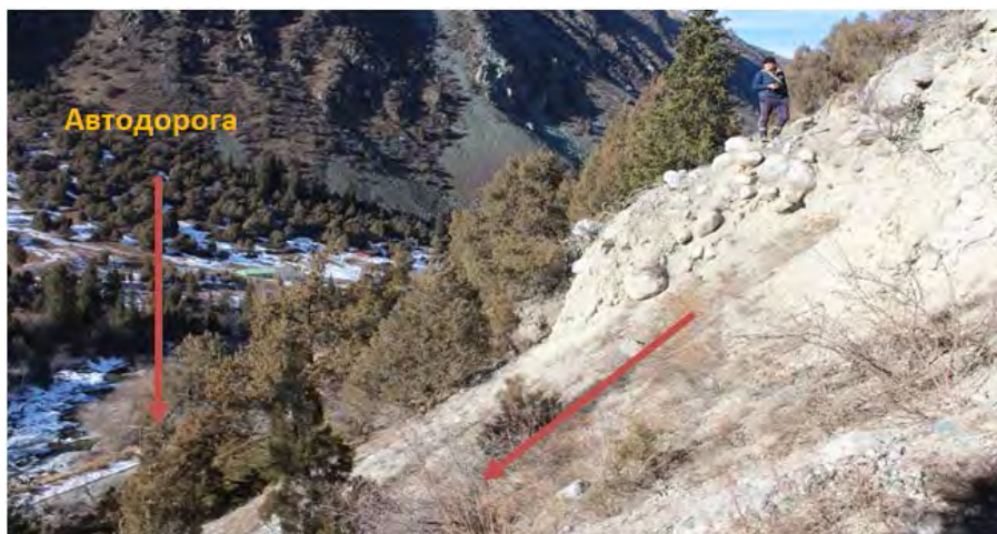
Рисунок 7 – Участок камнепадов «Ала-Арча 41 (28) км» на 28км автодороги Бишкек – Ала-Арча
