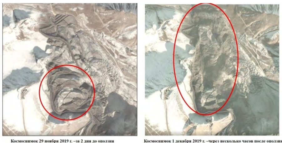
Рисунок 2 – Вид оползня отвалов вскрышных пород на руднике Кумтор (2019 г.)
