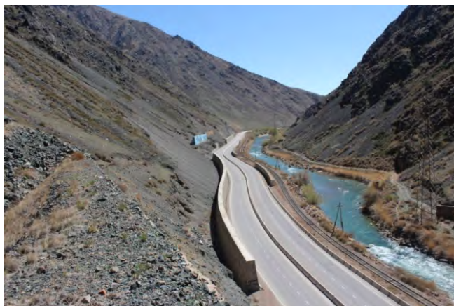
Рисунок 2 – Прорывной сай, с защитными стенками от осыпей и камнепадов
