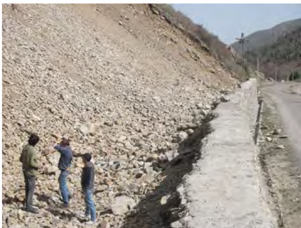
Рисунок 8 – Защитная стенка на обвально-осыпном участке «Ала-Арча 36 (23) км»
