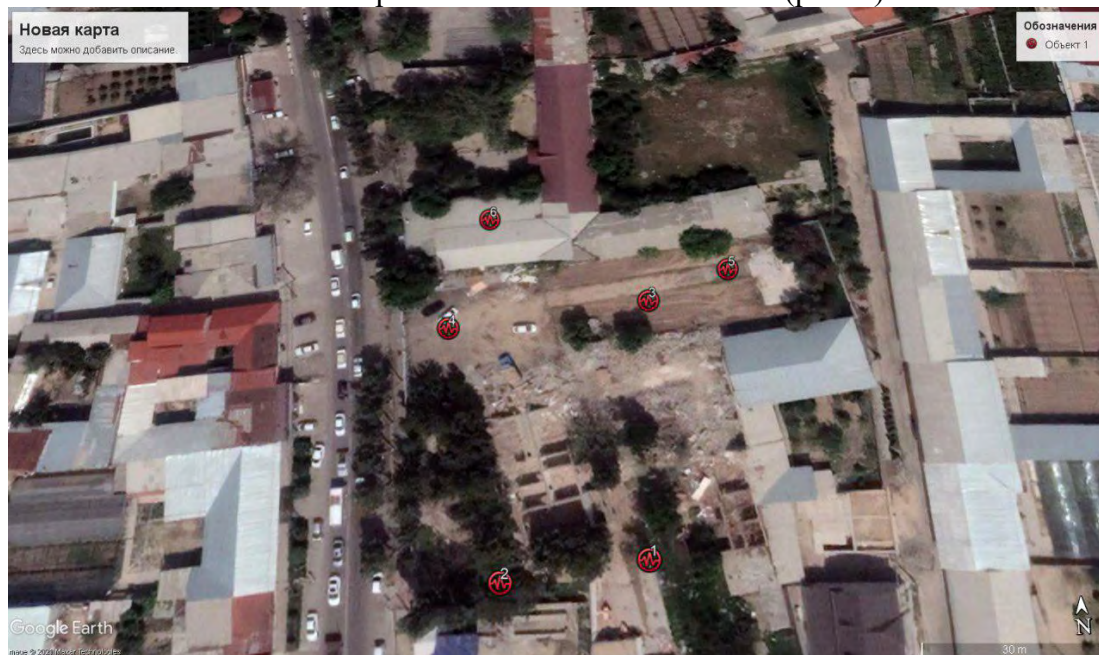
Рисунок 1 – Результаты оценки приращения сейсмической интенсивности за счет грунтовых условий площадки расположения объекта «Строительство многоэтажного жилого дома, расположенного по улице Хасанбой дом № 2 МСГ Хасанбой Гузар Ташкентского района Ташкентской области»
